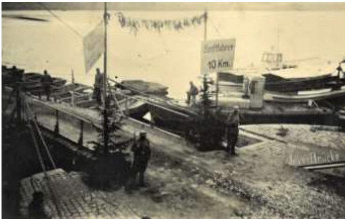
Abbildung: Velke-Brücke in Frankreich
