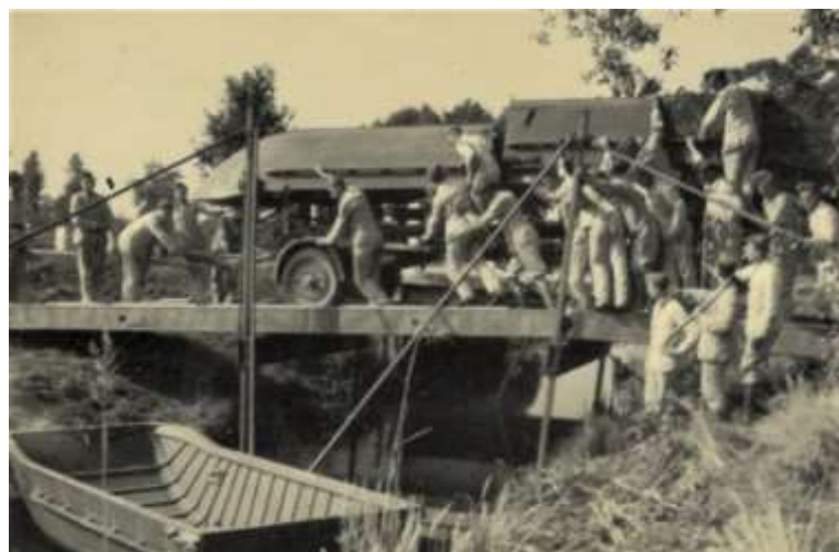
Abbildung: Übergang über eine Behelfsbrücke
