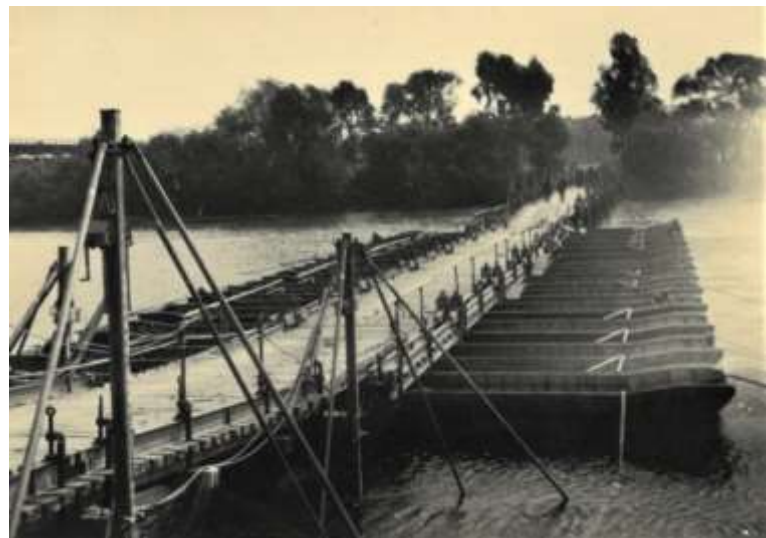
Abbildung: Behelfsbrücke in Frankreich
