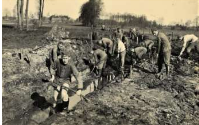
Abbildung: Arbeitseinsatz beim RAD – vermutlich bei Meliorationsarbeiten
